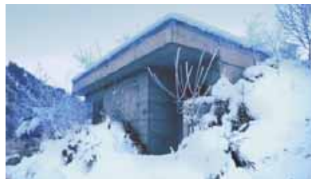
Fig. Poste d'observation d'une installation d'alarme-eau.
